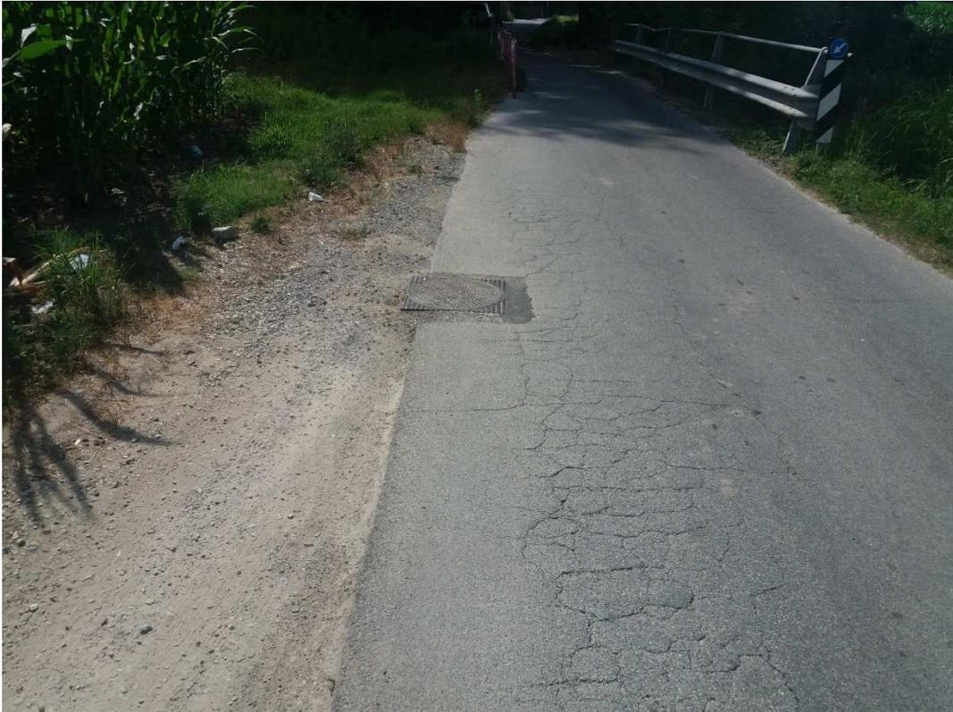
**Foto n. 2** Pozzetto di testata del collettore della fognatura nera a gravità
